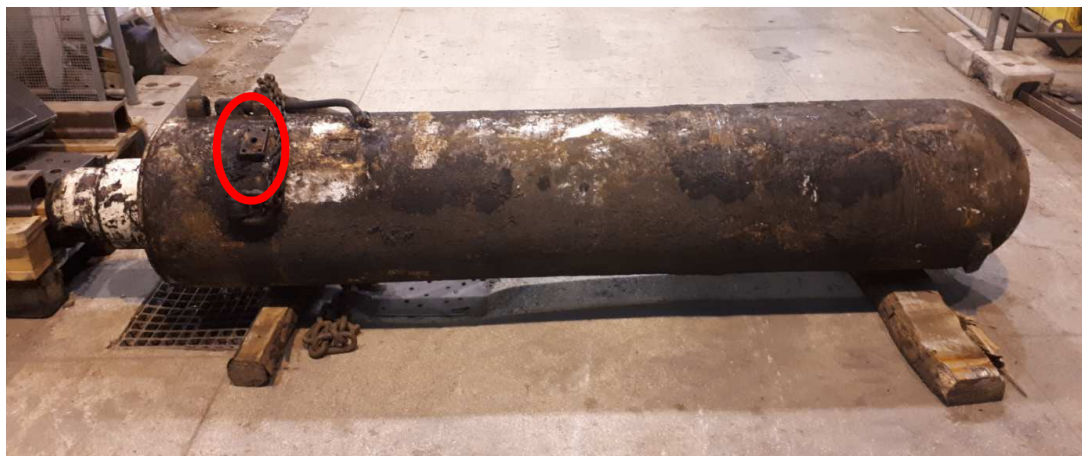
Fot. 10.2. Pozyskany do badań stojak o średnicy I stopnia \varnothing 0,37 m z zaznaczonym oryginalnym przyłączem (wyprowadzenie cieczy z podłoka PT wierceniami w płaszczu cylindra 3 \times \varnothing 0,009 m) (źródło własne)
