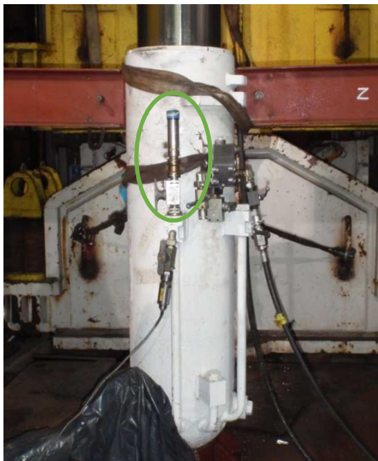
Fot. 10.8. Wariant trzeci podłączenia elementów hydraulicznych w układzie zabezpieczającym stojak (źródło własne)
