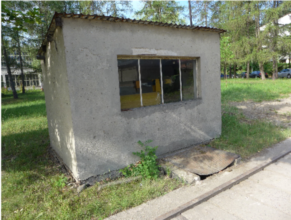
Fot.3. Budynek obsługi wagi samochodowej przewidziany do likwidacji.
