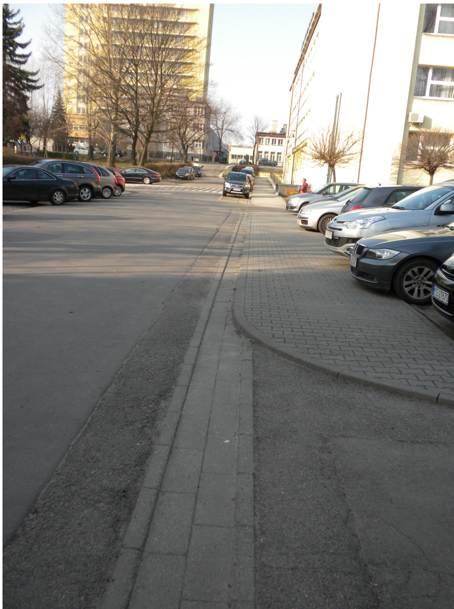
Fot.7. Ściek betonowy po stronie wschodniej stanowiący podstawę wytyczenia i dowiązania
