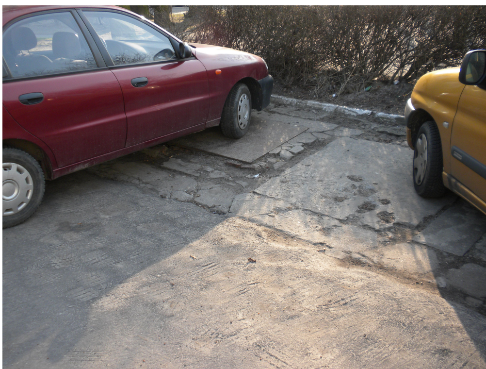
Fot.4. Studnia kablowa przewidziana do wymiany
