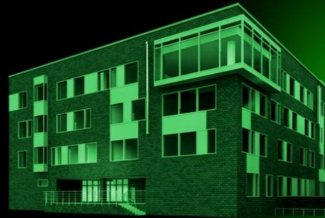
Budynek Centrum Czystych Technologii Węglowych
